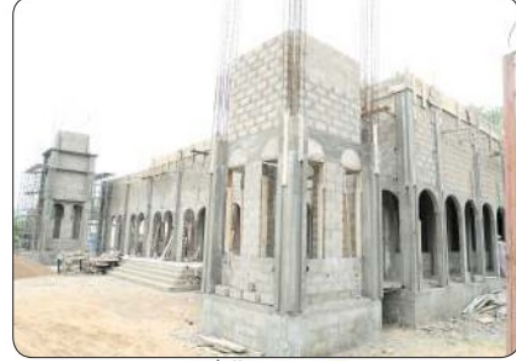
■ مسجد تحت التشييد
