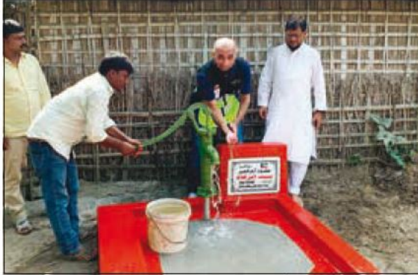
سلم الحمر اثناء حفر الآبار
