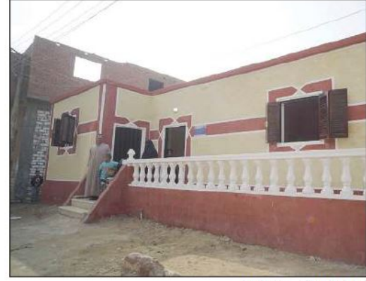
أحد المنازل التي تم بناؤها
