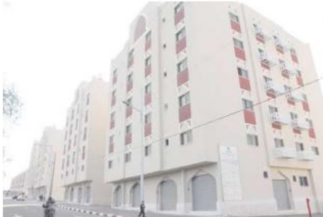
مبنى سكنية مساهمة للعمليات الفلسطينية
