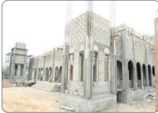
■ مسجد تحت التشييد
