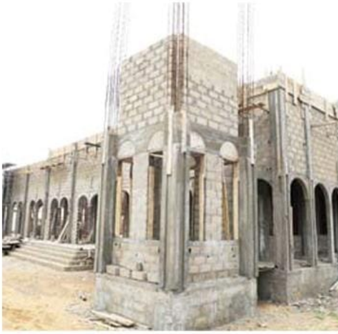
مسجد قيد البناء
