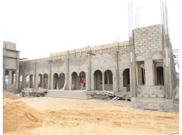
مسجد تحت البناء
