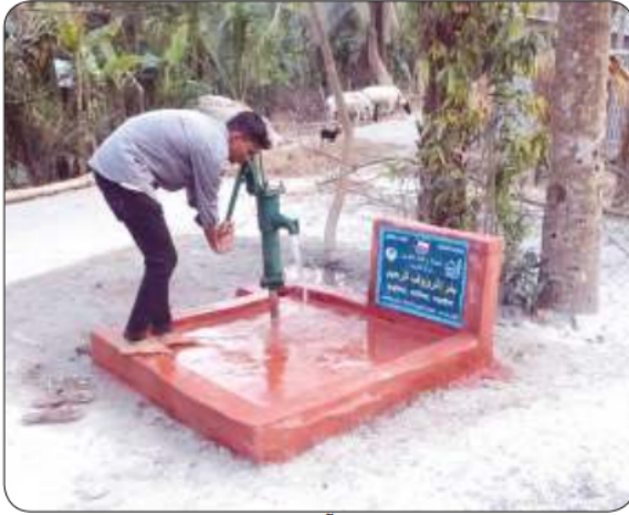
حفر آبار المياه
