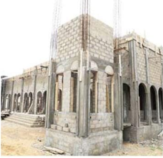
مسجد قيد البناء
