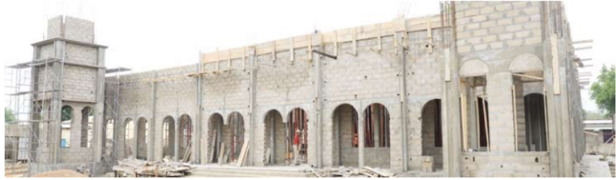
مسجد قيد البناء
