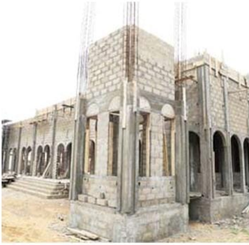
مسجد قيد البناء
