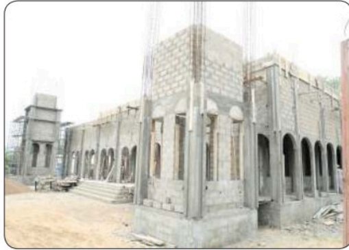
■ مسجد تحت التشييد
