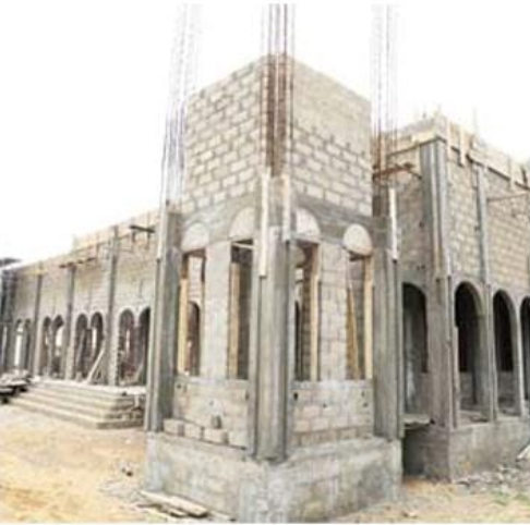
مسجد قيد البناء
