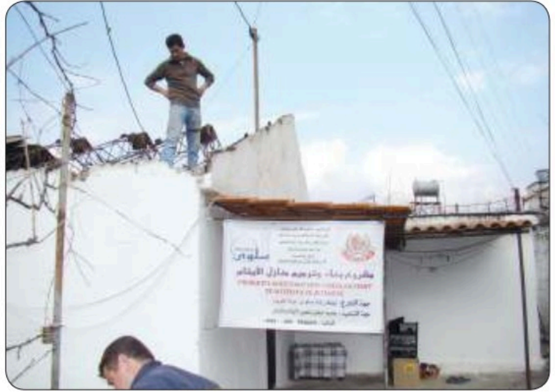
ترميم بيوت فقراء
