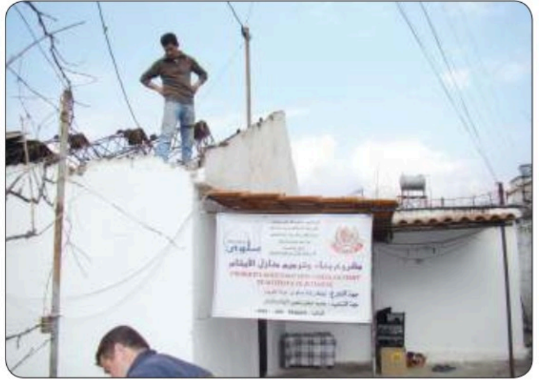
ترميم بيوت فقراء
