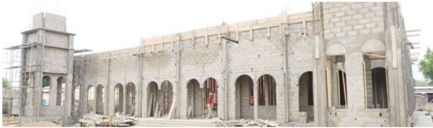
مسجد قيد البناء
