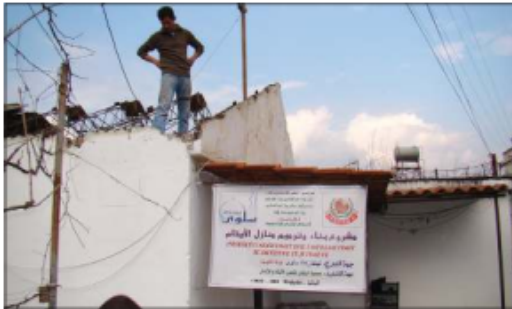
جانب من ترميم بيوت فقراء
