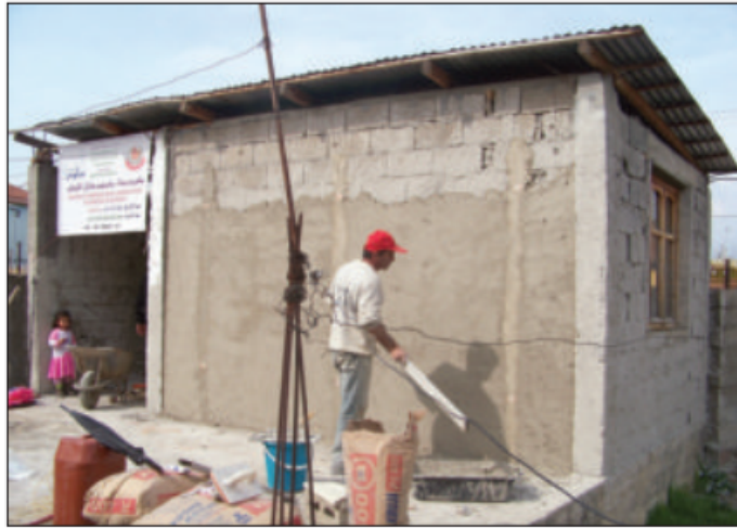
جانب من أعمال الترميم
