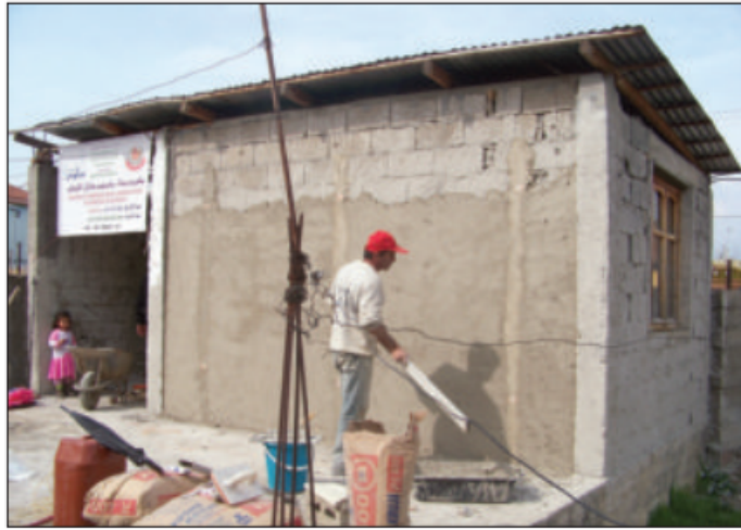
جانب من أعمال الترميم
