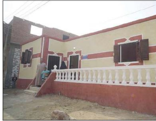
أحد المنازل التي تم بناؤها
