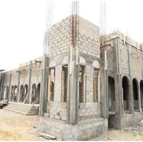
مسجد قيد البناء
