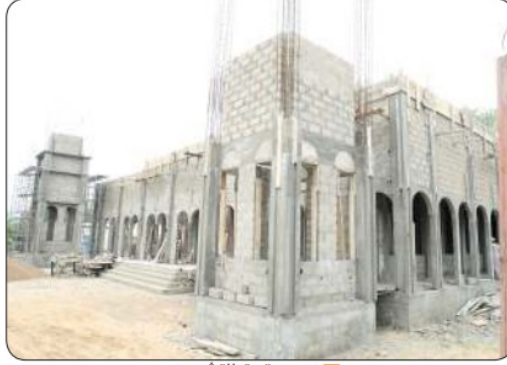
مسجد تحت التشييد
