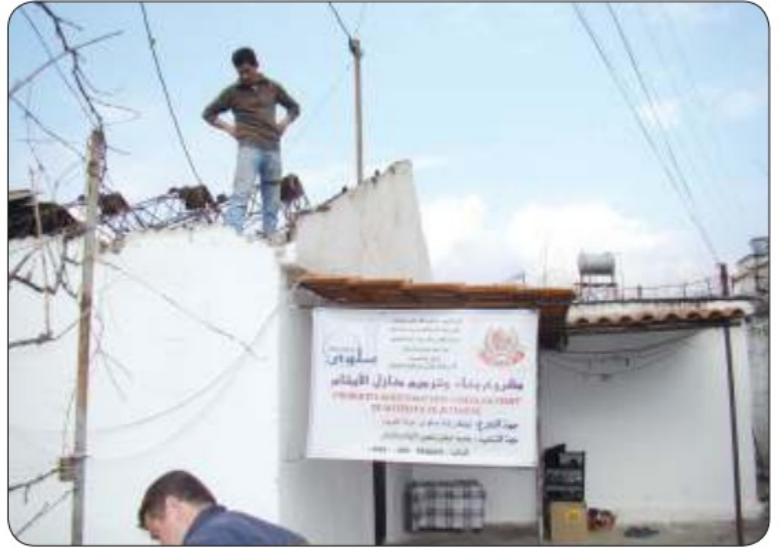
■ ترميم بيوت فقراء
