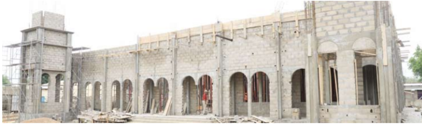
مسجد قيد البناء
