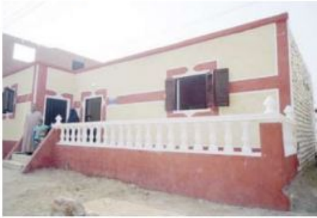
أحد المنازل التي تم بناؤها
